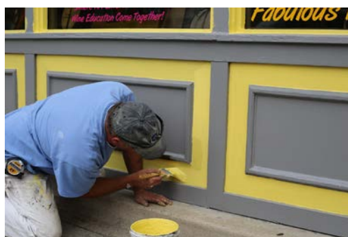
Image 9. Travail dans le bâtiment
