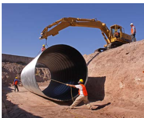
Image 6. Travail dans la construction
